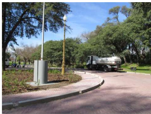
Rotonda de distribución interna de calles de pavimento articulado
